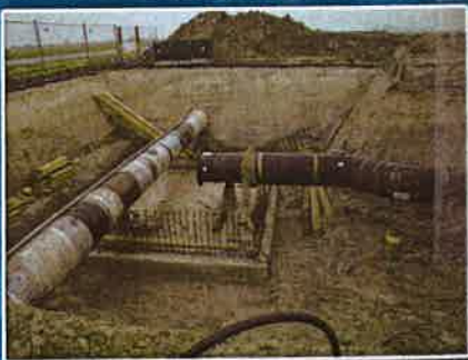
Rabattement de nappe dans fouille technique. (Equipement hydraulique)
