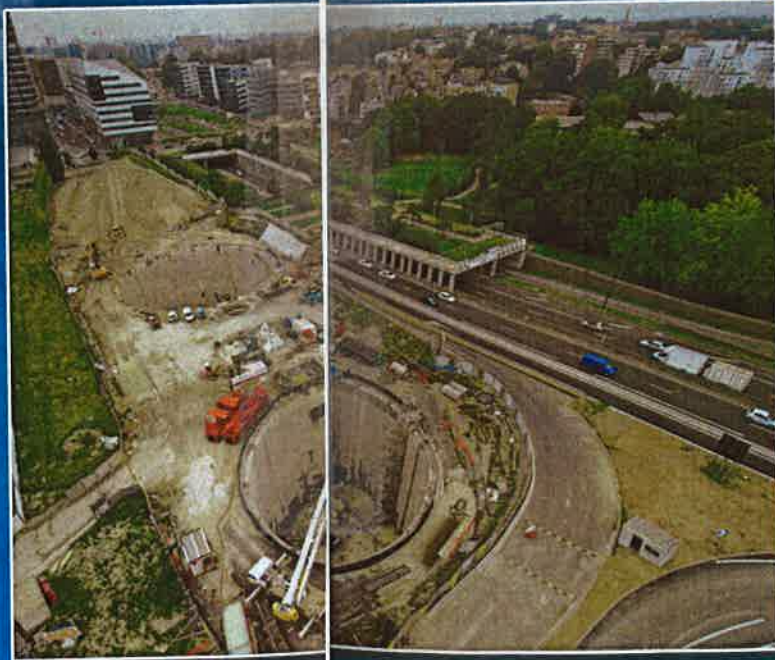
Rabattement de nappe par puits profonds.
