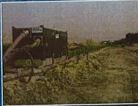
Rabattement de nappe pour pose de réseau d'assainissement.
