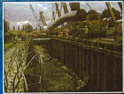
Rabattement de nappe dans fouille blindée. (Pose de pipe)
