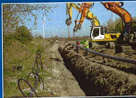
Rabattement de nappe pour fouille en tranchée. (Pose de pipe)
